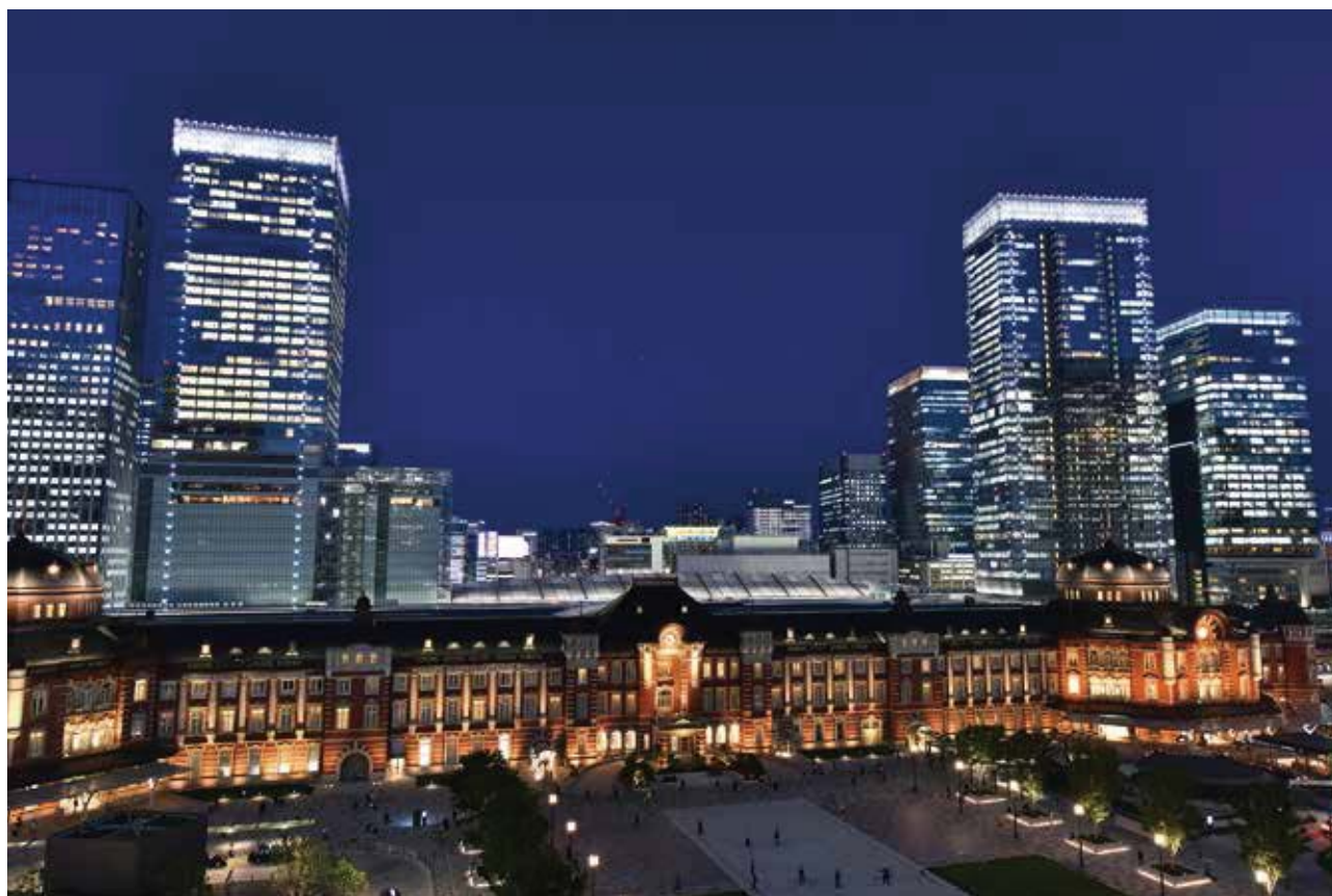
圖六 復原後的東京站丸之內站房外觀與東京市中心大樓群的夜景（施哲仁醫師拍攝）。八重洲（東）側的四棟超高層大樓由左而右分別為Marunouchi Trust City、GranTokyo北棟、南棟與Pacific Century Place丸之內。
