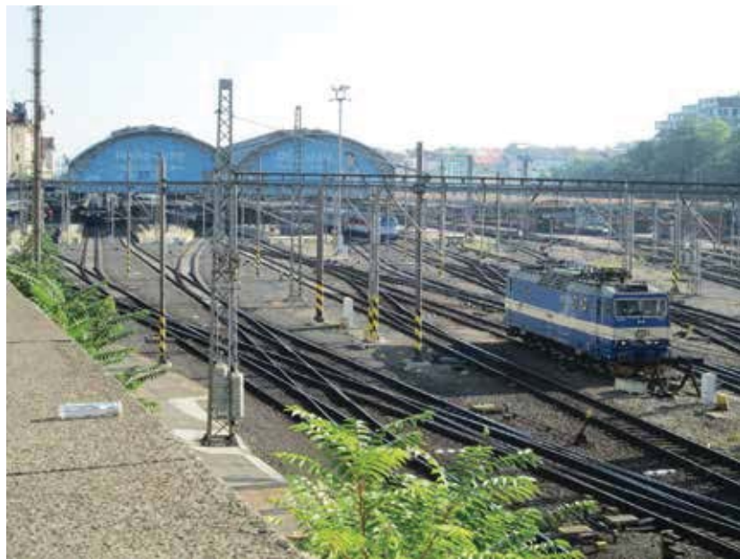
圖二 捷克布拉格火車總站(Praha hlavní nádraží)，1871年落成啟用。雖然位於「新城(New Town)」區域、1845年啟用的馬薩里克車站(Praha Masarykovo nádraží)才是布拉格最古老的車站，但是兩者都在市中心與眾多列名世界遺產的老建築（背景處）共存，一直到現在還是原地改建與翻新。照片中可見兩個覆蓋月臺及軌道的巨大棚架(train shed)，這種設計在歐洲的車站比較常見，只有照到一部分的站房位則於最左邊，本站採用「通過式」的設計，站房的位置在南北走向的軌道與月臺西側而非位於端點。
